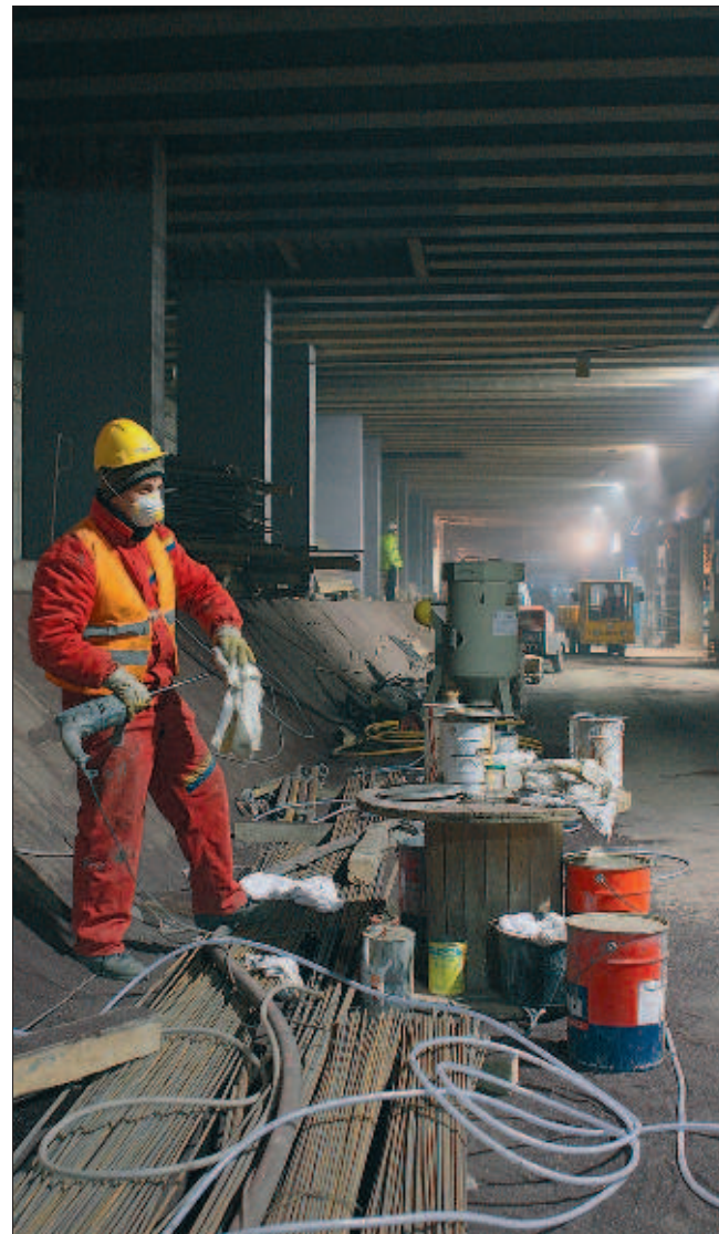
Prace związane z wykończeniem prawie półtorakilometrowego tunelu dla szybkiego tramwaju mają zostać zakończone do października tego roku
