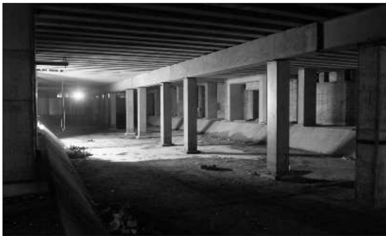
Gotowy tunel tramwajowy pod ul. Lubomirskiego. Czy tędy poprowadzi pierwsza linia krakowskiego metra?
